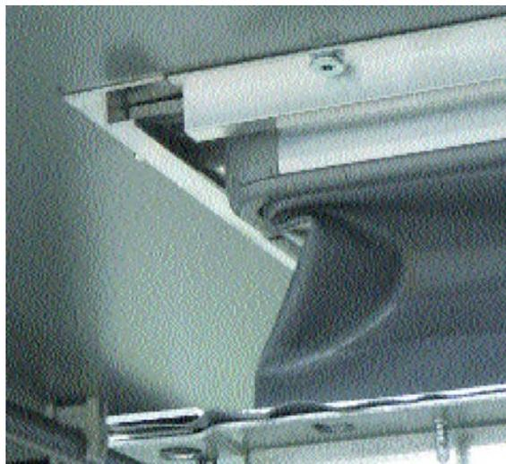
Detail flexible fan connection
