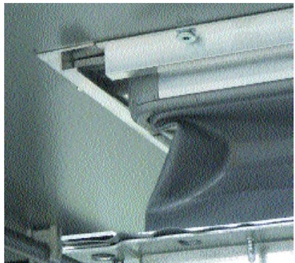
Detail flexible fan connection
